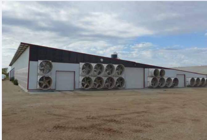
Mechanische Quer- und Windtunnelbelüftungen kühlen die Kühe im Sommer und sorgen stets für frische Luft im Stall. Im Bild ein Stall für 400 Kühe an Melkrobotern mit Windtunnelbelüftung.
