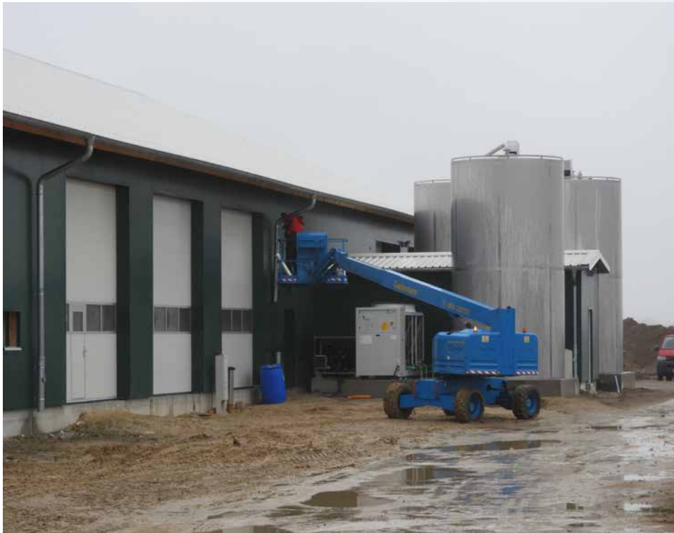
Draußen wird noch letzte Hand angelegt, drinnen wird schon gemolken.
