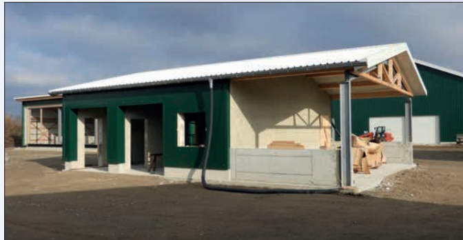
Die Kälberküche zur Vorbereitung der Tränkmilch mit angeordnetem Sammelbereich für die zu verkaufenden Bullenkälber.
