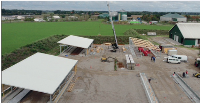
Im Bau: Vier identische Kälberställe werden um die Kälberküche herum angeordnet.
