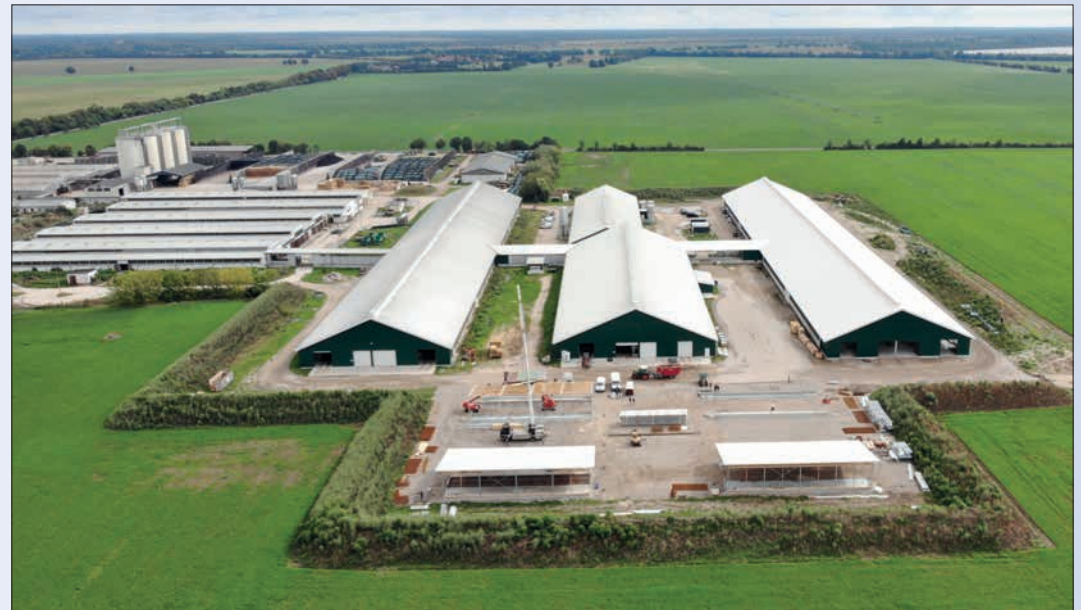
Milchgut Görlsdorf in Brandenburg: In den letzten Jahren wurde die Milchviehhaltung komplett neu aufgestellt. Im Vordergrund entstehen die Ställe für die Tränkkälber
