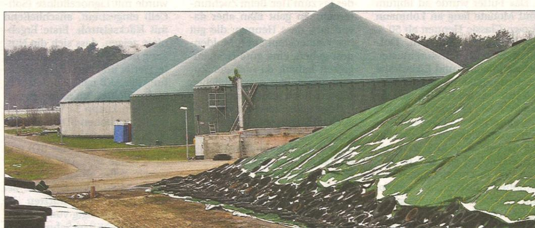
Die Fermenter der Biogasanlage werden mit Maissilage sowie mit Gülle und Festmist beschickt.
