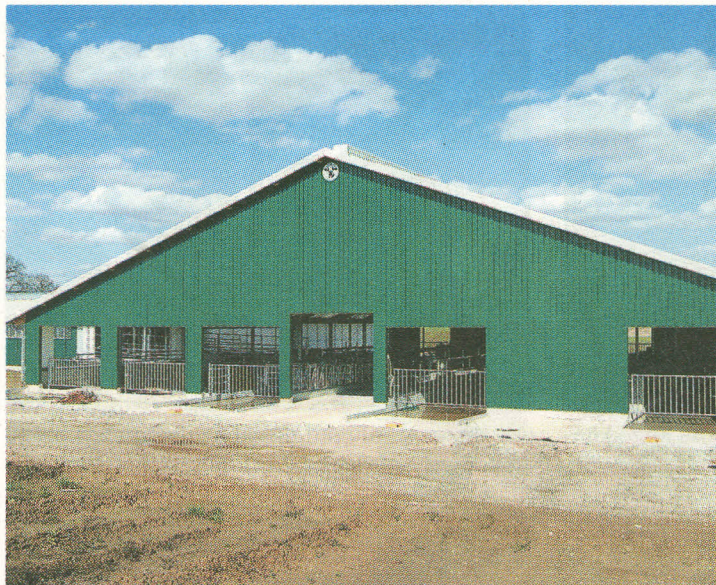
Der neue Kuhstall steht kurz vor der Vollendung. In der kommenden Woche ist ein Tag der offenen Tür geplant.
