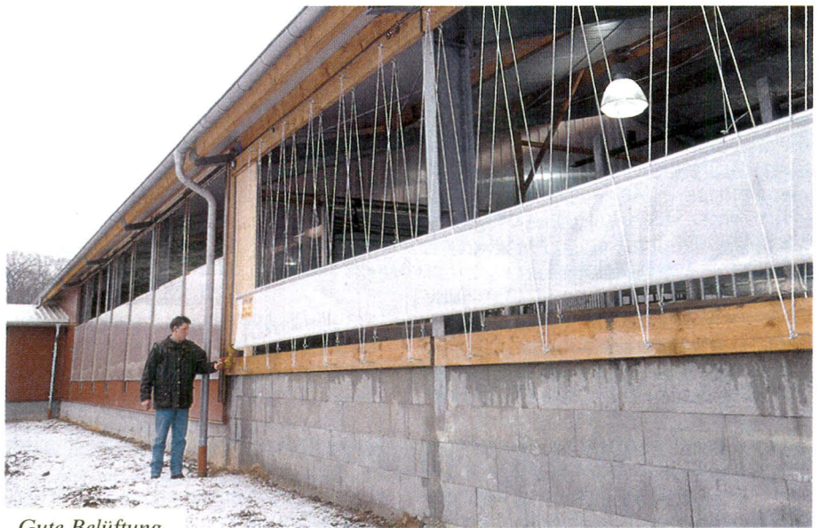
Gute Belüftung im Sommer: Doppelstegplatten am Melkstand. Curtains am Vorwartehof. Beide sind mit Kurbeln stufenlos verstellbar.
