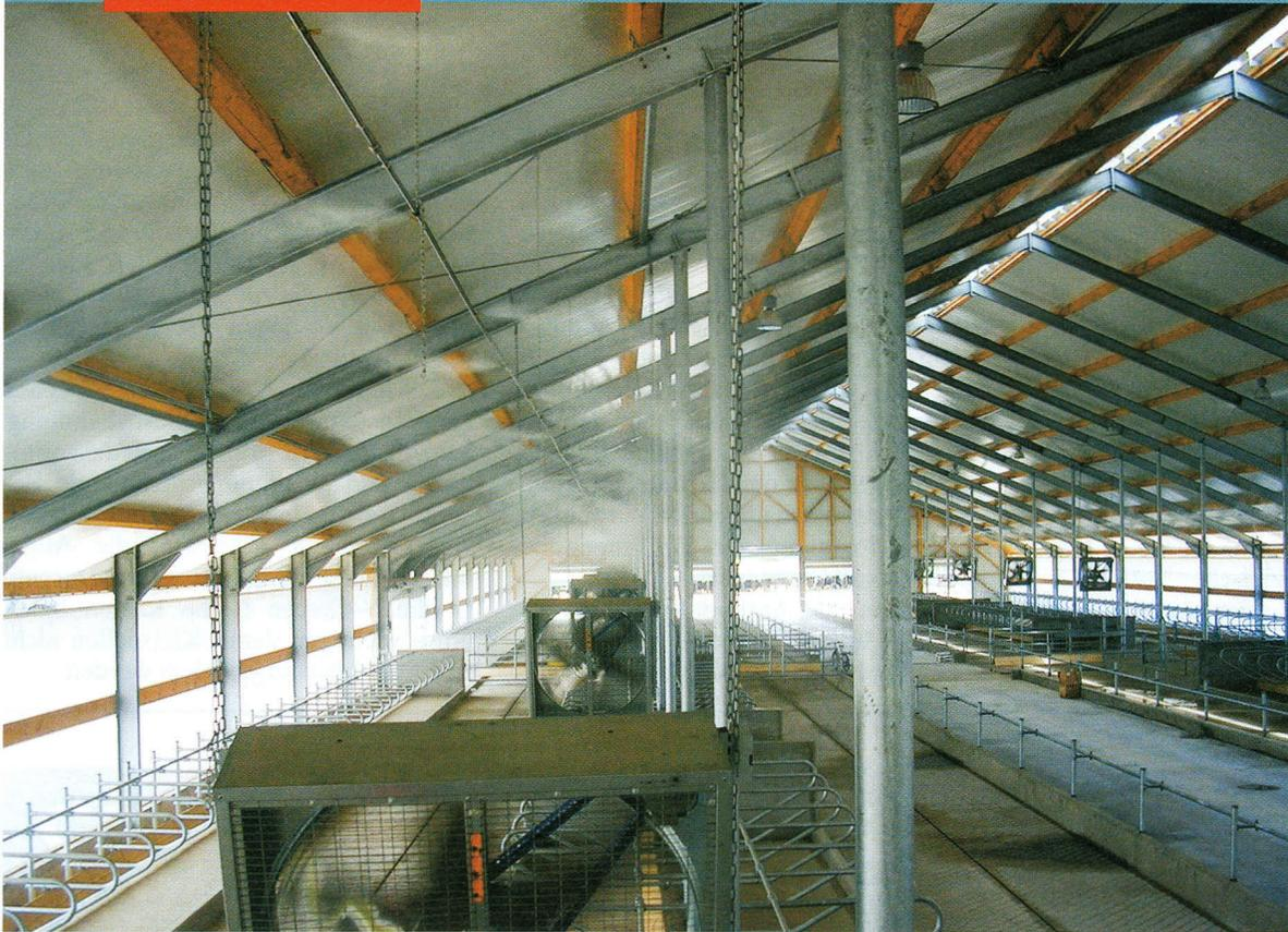
Über den Ventilatoren wird mit Spezialdüsen Wasser vernebelt und so die Luft gekühlt. Die gekühlte Luft sinkt ab und wird mit dem Luftstrom der Ventilatoren verteilt.
