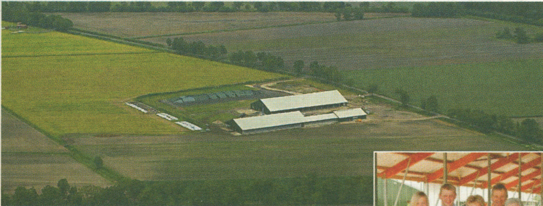
Der neue Stall wurde außerhalb vom Ort errichtet.
