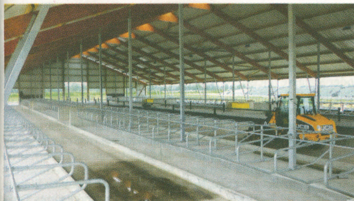
Der Neubau ist als sechsstreihiger Stall mit 298 Tierplätzen und mittigem Futtertisch erstellt worden.
