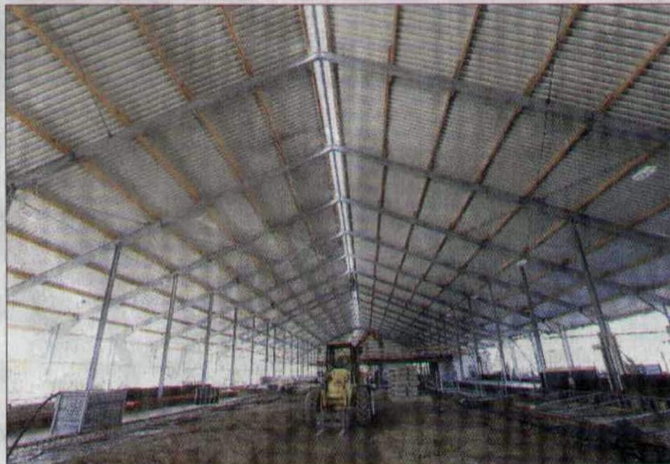
Der neue Stall wird 110 Meter lang, 40 Meter breit und bietet den Tieren dank neun Metern Raumhöhe und intensiver Lüftung ein gutes Klima. In den alten Ställen liegt die Höhe bei höchstens drei Metern.
